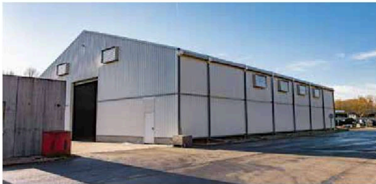
Quai de transfert
