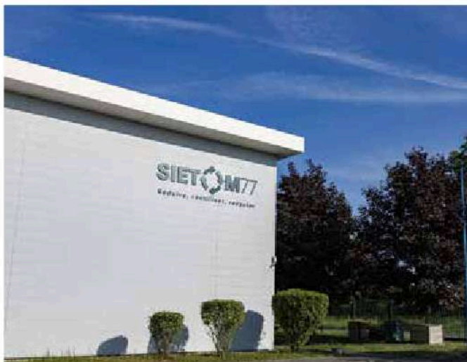
Enseigne côté parking
