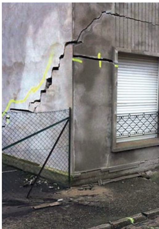
Fissures suite à un retrait gonflement d'argile.
