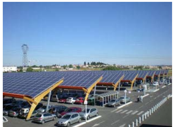
Figure 4 : Installation solaire PV sur parking (source : http://www.sunvie.eu/ombriere-photovoltaique.html )
