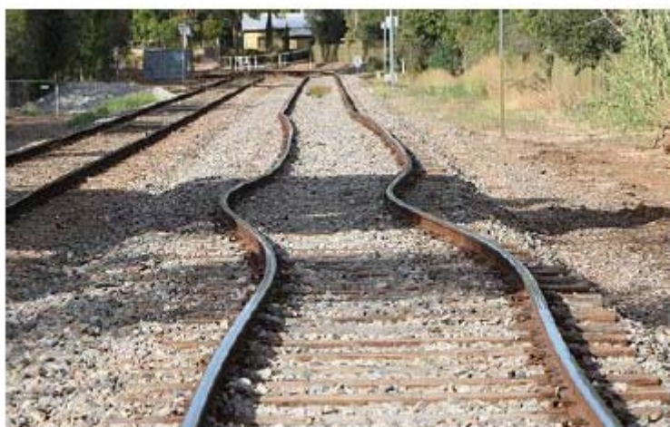
Déformation de rails lors de la canicule de 2003 sur la ligne du RER D
