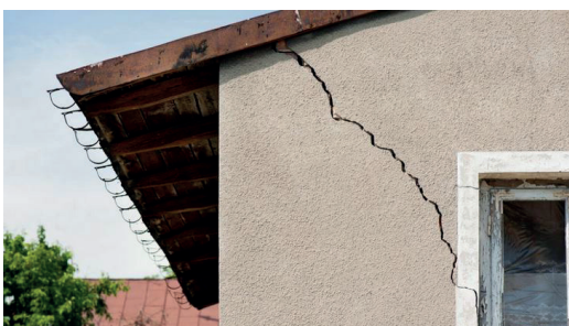
Fissure suite à un retrait/gonflement d'argile (mouvement de terrain différentiel consécutif à l'assèchement et à la réhydratation des sols).
