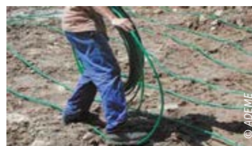
Pose de capteurs horizontaux pour l'installation d'une pompe à chaleur géothermique.
