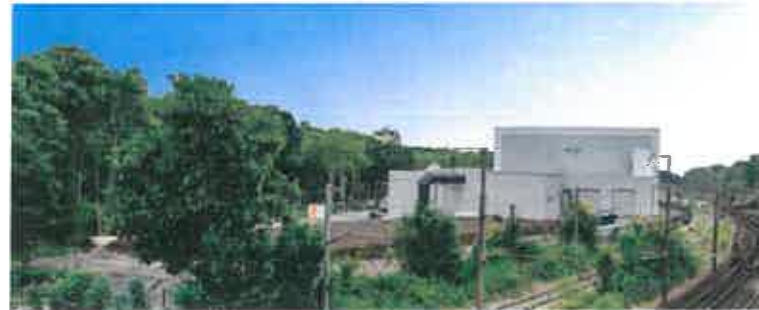
Unité de Valorisation des Ordures Ménagères
